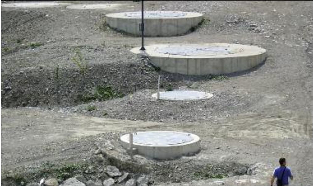
Slika 1: Slovenski gradbeniki so zelo ponosni na sistem odvodnjavanja v zgornjem delu zemeljskega plazu Slano blato, ki so ga končali leta 2007 in združuje enajst vodnjakov, skopanih do drsne ploskve plazu nekaj deset metrov globoko, ter podzemno in površinsko drenažo. Ponosni so zato, ker na plazu niso opazili premikov ob obilnih padavinah in poplavih septembra 2010, ko se je sprožil bližnji zemeljski plaz Stogovci.
