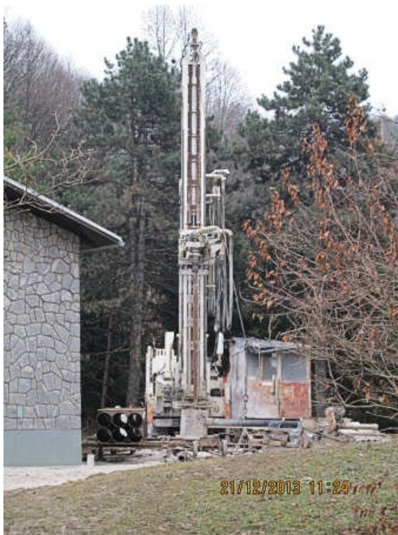
Slika 3) Nova vrtina v črpališču Poljčane 3
