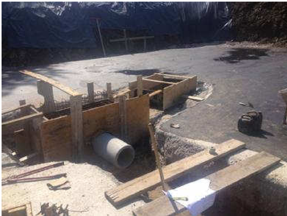
Slika 2) Priprava za temeljno ploščo pri črpališču Poljčane 2
