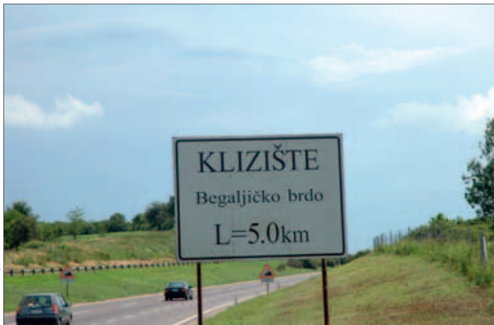
Slika 1: Avtocesta Beograd–Niš na odseku pri Begaljičkom brdu poteka 5 km po močno plazovitem območju.
