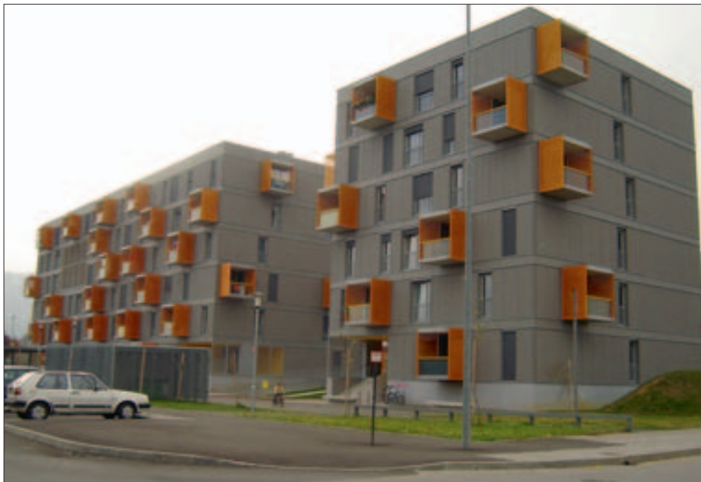
Slika 6: Primer organizirane stanovanjske gradnje – večstanovanjske zgradbe, neprofitna stanovanja (Studenci).
