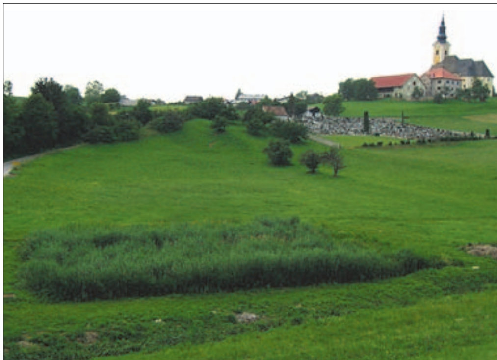
Slika 1: Rastlinska čistilna naprava Ponikva (za 350 PE, površina: 600 m 2 ) spominja na nekoliko zaraščeno gredo.
