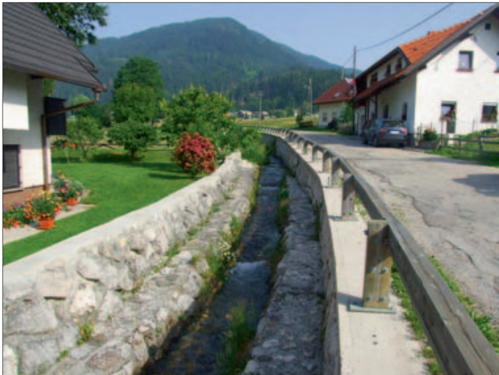
Slika 1: Zaradi hudourniškega značaja je potok Krotnjek na celotnem odseku toka skozi vas Podkoren reguliran.
